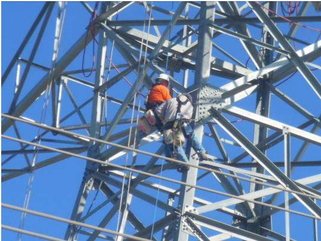
Figure 6: PAR crews torquing bolts at Tower M29-T4, Segment 7.
