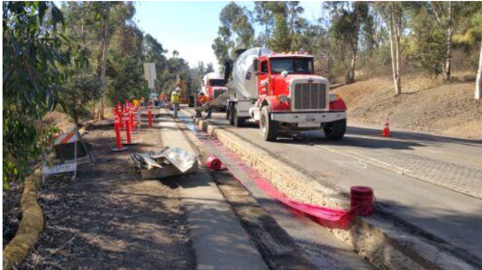
Caption Concrete pour on Pomerado Road.
