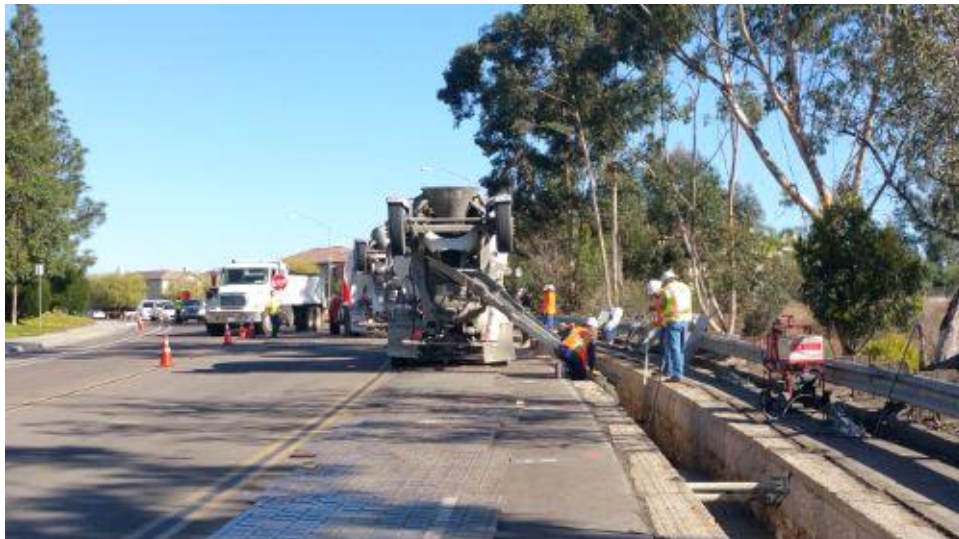
Caption Concrete pour on Pomerado Road.
